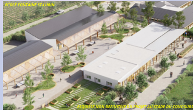
Lancement Projet rénovation / restructuration du pôle élémentaire
