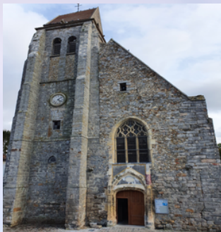
Poursuite travaux de rénovations de l'église
